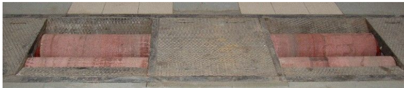
Obr. 1 Válcová zkušebna Fig. 1 Roll test room
