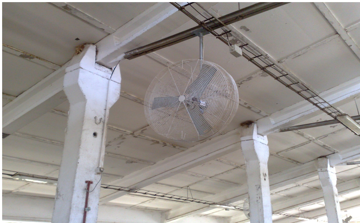
Obr. 2 Úprava mikroklímy v ustajňovacom priestore pomocou ventilátoru Fig. 2 Reform mikro conditioning in stall field trough the medium ventilator
