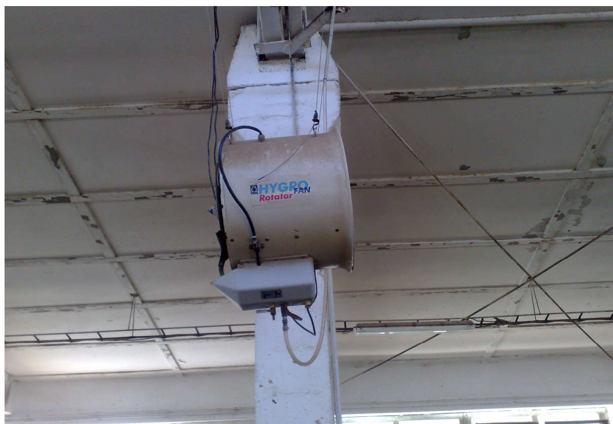
Obr. 3 Úprava mikroklímy v ustajňovacom priestore pomocou vodnej dýzy Fig. 3 Reform mikro conditioning in stall field trough the medium water jet
