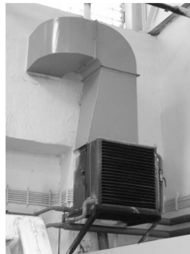
Obr. 2 Teplovzdušný výmenník Figure 2 Air-heating exchanger
