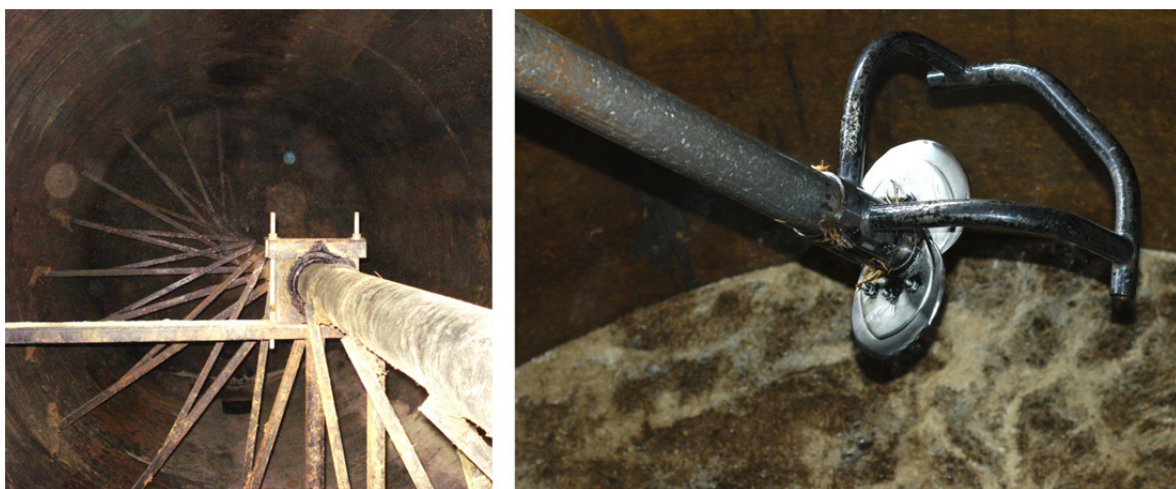
Obrázok 8 Uloženie miešadla horizontálneho fermentora, rýchlobežné vrtuľové miešadlo z predmiešacej nádrže Figure 8 Bearing of a horizontal fermentor blender, pre-mixing tank high-speed propeller stirrer
