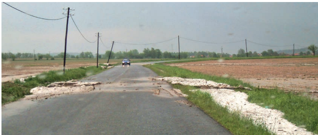
Foto 89: Konfliktní křížení dráhy soustředěného odtoku v kritickém profilu silničního propustku.
