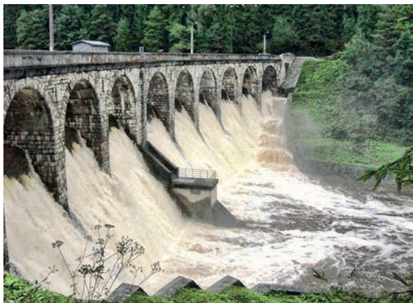
Foto 5: Hráz představené vodní nádrže Sedlice za povodně 14. srpna 2002. Zdroj: Kvítek T.
