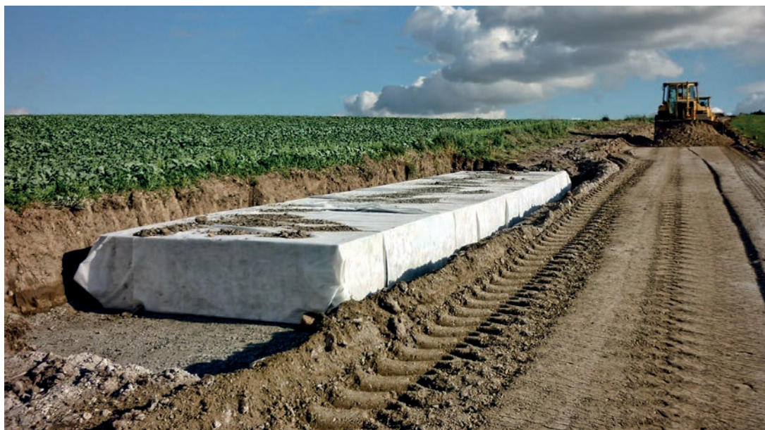
Foto 101: Zasakovací galerie pod ornou půdou. Zdroj: Mazín V.
