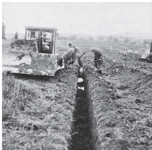
Foto 28: Buldozer pro zahrnování drenážní rýhy.
