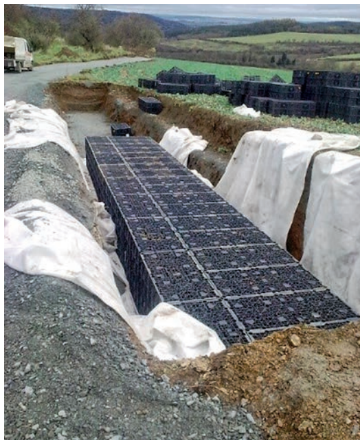
Foto 100: Zasakovací galerie na svodných a záchytných příkopech. Zdroj: Mazín V.
