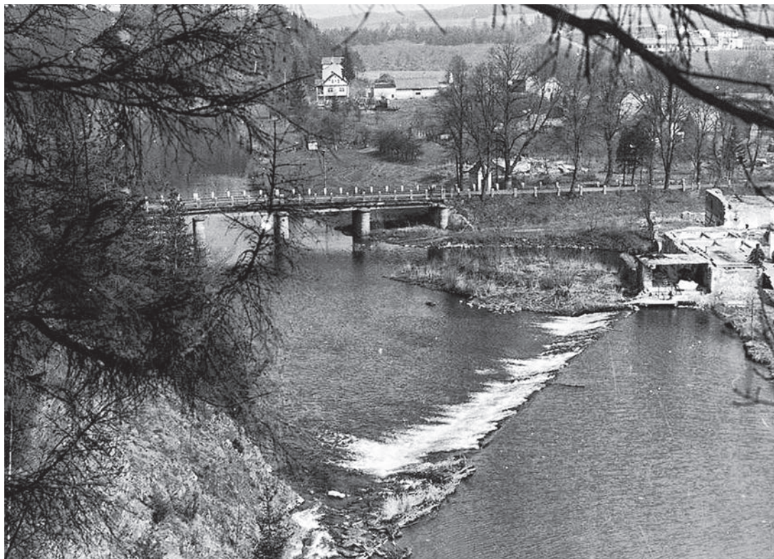
Foto 69: Demolice mlýna v obci Zahrádka (nad mostem). Zdroj: Povodí Vltavy, státní podnik
