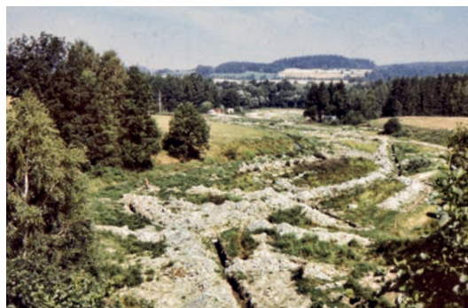
Foto 29: Celkový pohled na realizaci stavby odvodnění v nivě. Zdroj: Kvítek T.
