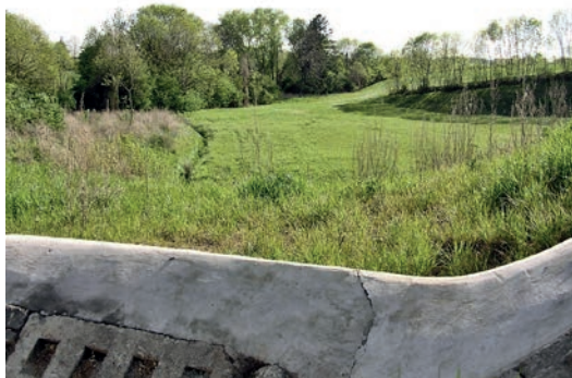
Foto 108: Hráz suché nádrže v nivě.
