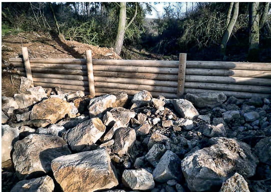
Foto 91: Balvanitý skluz pod vybudovanou přehrázkou. Zdroj: Mazín V.
