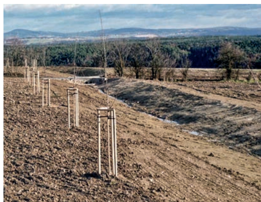
Foto 96: Zasakovací průleh s propustkem.
