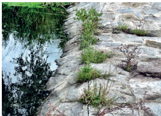
Foto 110: Detail hráze rybníčku a malým retenčním prostorem nad stálou hladinou. Zdroj: Kvítek T.
