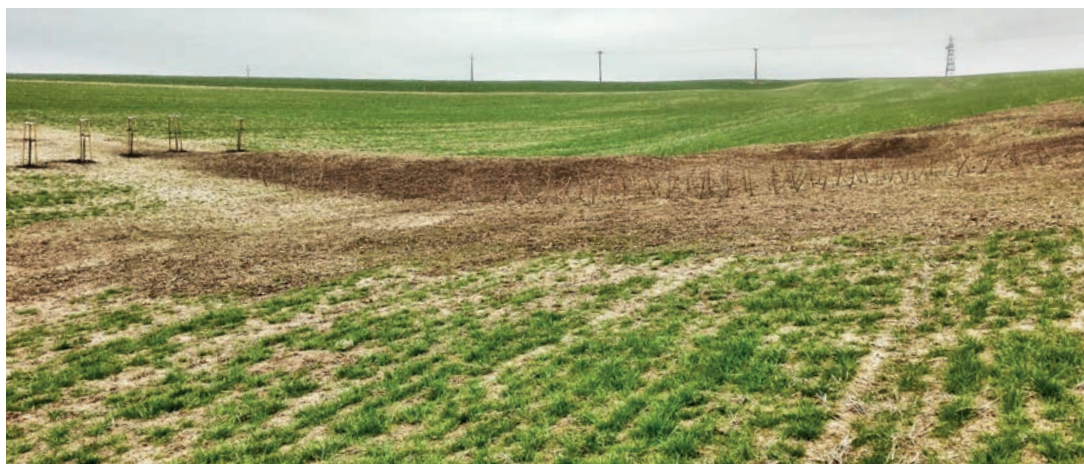
Foto 104: Víceúčelová hrázka v údolnici. Zdroj: Karásek P.
