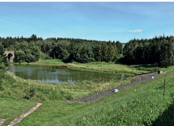
Foto 3: Hráz představené vodní nádrže Němčice.
