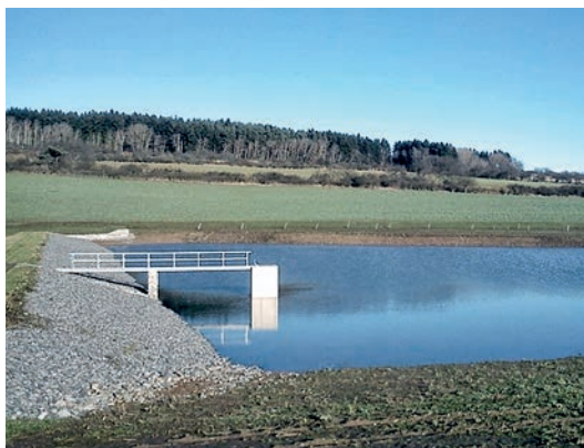
Foto 109: Hráz malé vodní nádrže. Zdroj: Mazín V.
