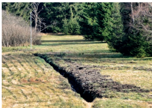
Foto 62: Odvodnění pomocí příkopů. Zdroj: Kvítek T.
