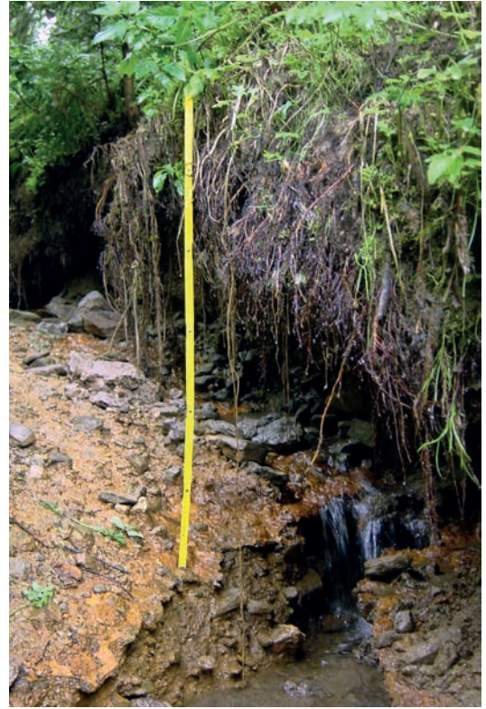
Foto 57: Nepropustná stmelená vrstva (ortštejn) v hloubce 1 m vytváří podmínky pro rychlý podpovrchový odtok z lesních porostů. Zdroj: Kvítek T.
