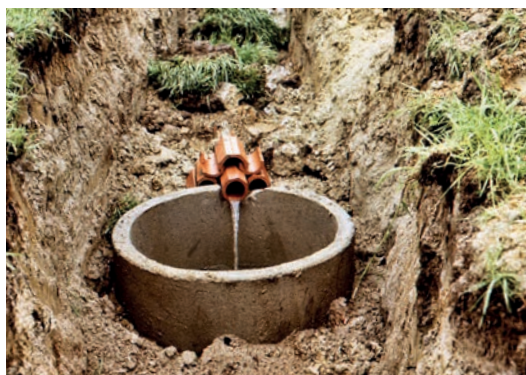
Foto 30: Část drenážní šachtičky s odtékající podchycenou vodou během výstavby drenážního systému. Zdroj: Kvítek T.
