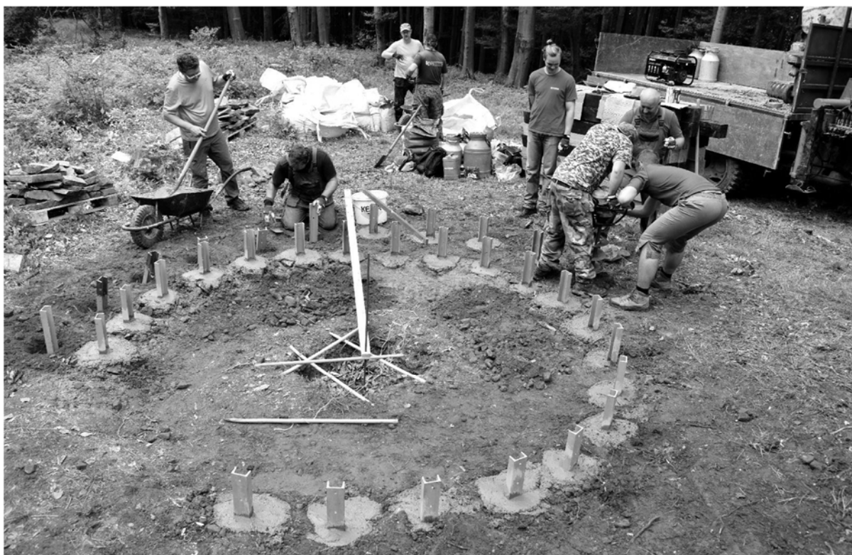
Obr. 4. Vrtanie dier a betonáž kovových konzol stĺpov
