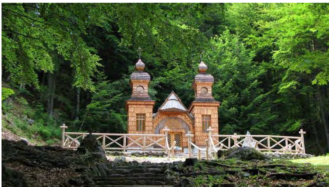
Obr. 5: K 100. Výročiu bola kaplnka obnovená.
