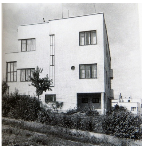
Obr.2: Východní průčelí, orientované zahrad, cca 1930
