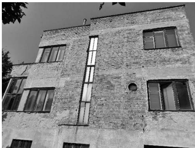
Obr.3: Lužická 4, východní průčelí, 2017
