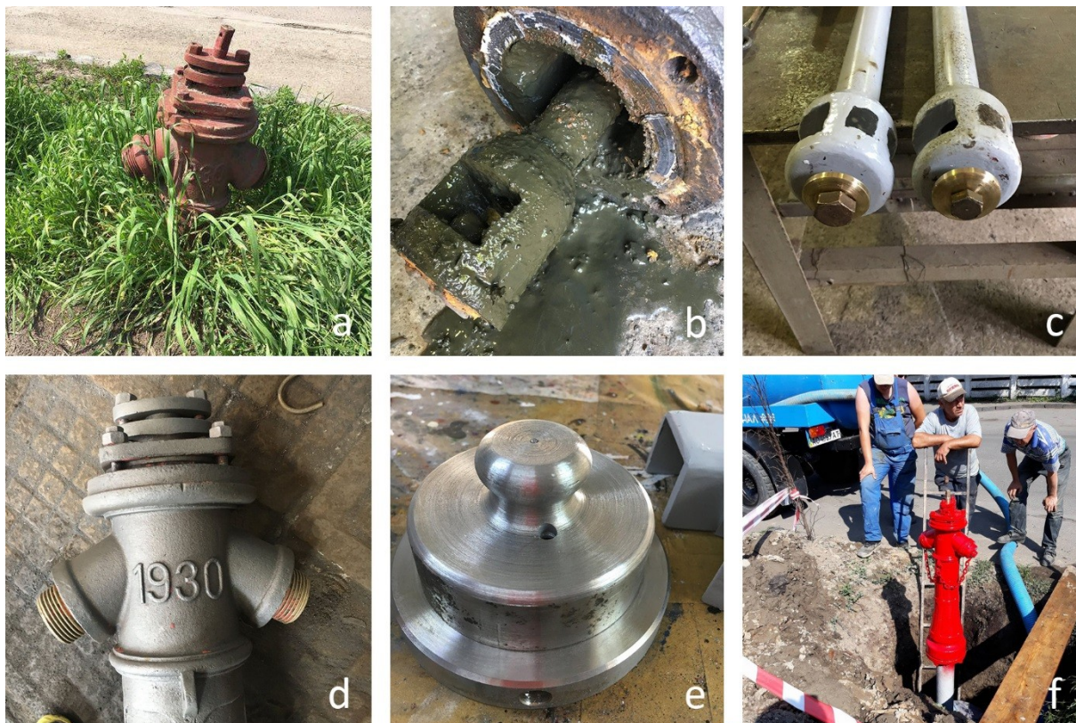
Obr.3: Proces obnovy funkčnosti hydrantu: a) požiarny hydrant pred obnovou; b) stav ventilu demontovaného hydrantu; c) ventily po oprave; d) liatinové teleso hydrantu po pieskovacích prácach; e) nový uzáver závitového hrdla, vyhotovený z ocele pomocou obrábania kovov; f) inštalácia obnoveného hydrantu. (Foto Jevhenija Kovaľčuka)
