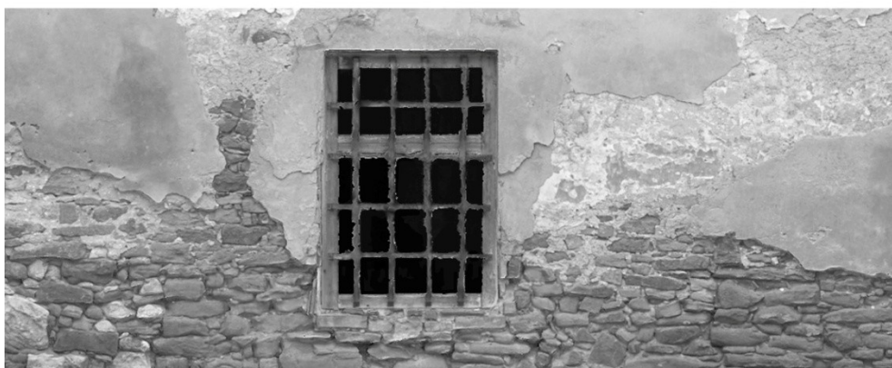
Obr.4: Fotoplán fasády historickej budovy a detail jedného okna
