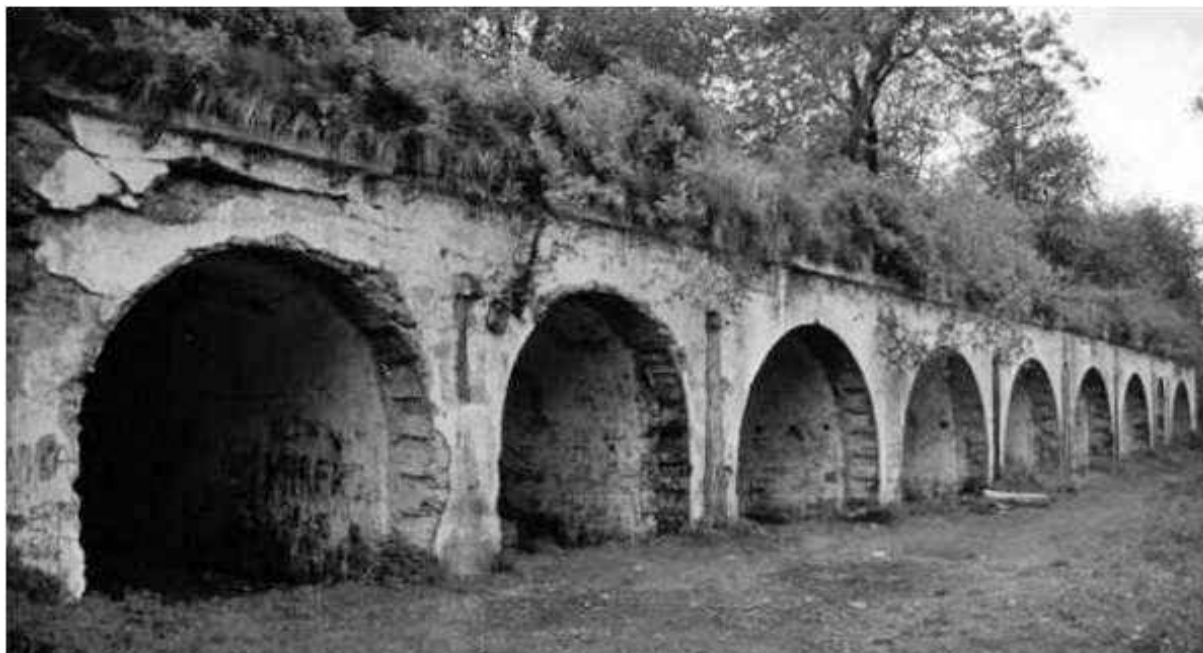
Obr.7: Opevnenie V. - Grochowce: Pohľad na parciálnu časť opevnenia. Zdroj: Archív M. Gosztyla.
