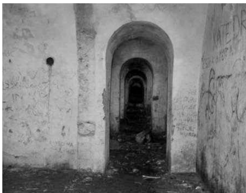
Obr.8: Opevnenie V. - Grochowce: Pohľad do vnútra opevnenia. Zdroj: Archív M. Gosztyla.
