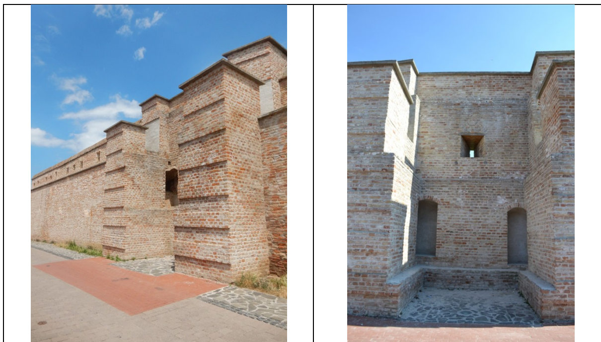
Obr.1: Ukážka obnovy veže opevnenia s použitím metódy „architektonizovanej ruiny“ pri náznaku zaniknutých častí objektu. (Fotoarchív Jany Gregorovej)
