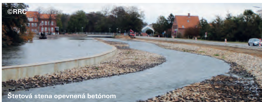
Vybudovanie štetovej steny pre zriadenie hate
