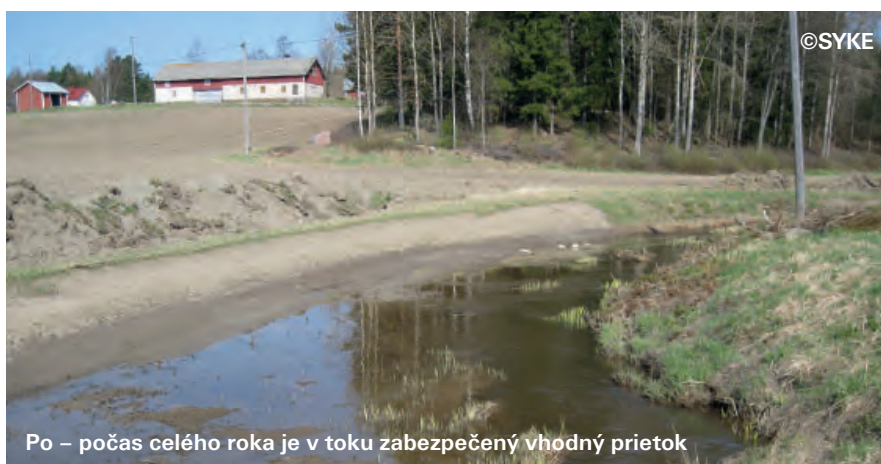
Na ľavom brehu potoka bola vybudovaná záplavová terasa. Právý breh bol ponechaný bez zásahu. Zemina vykopaná pre záplavovú terasu sa použila na príľahlých poliach.
