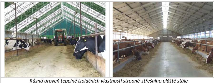
Různá úroveň tepelně izolačních vlastností stropně-střešního pláště stáje
