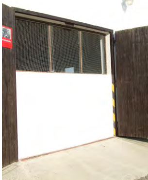
Sítě proti ptákům nebrání provětrávání stáje
