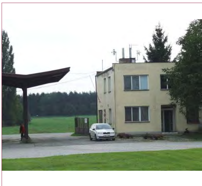
Obr. 5. Veterinárně kontrolní smyčka se nachází na okraji farmy
