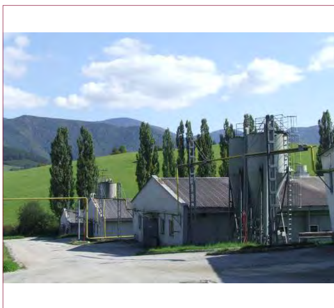
Obr. 46. Dostatečná vzdálenosti mezi jednotlivými stájemi brání vzájemnému nasávání vzduchu mezi stájemi
