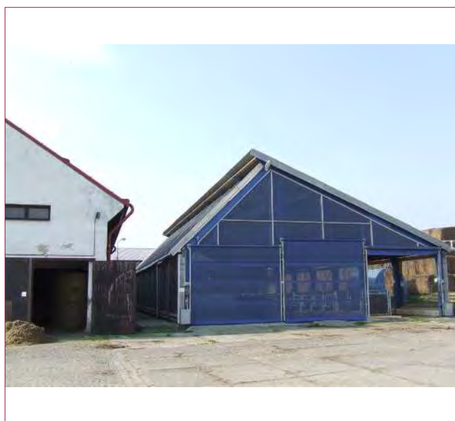
Obr. 47. Při malé vzdálenosti mezi jednotlivými stájemi dochází k vzájemnému nasávání vzduchu mezi stájemi
