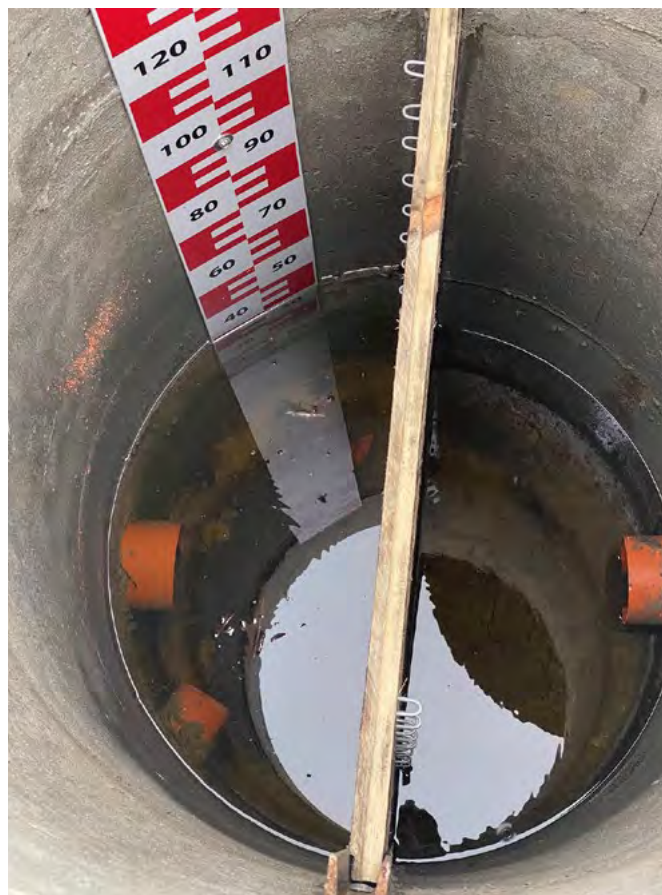
Obrázek 28 – Rekonstruovaná šachta meliorací s hradítky před montáží senzorů
