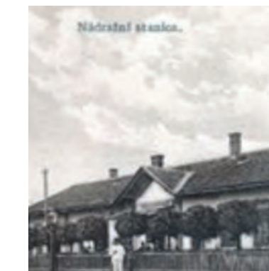
POSTAVENIE ŽELEZNIČNEJ TRATE 1897
