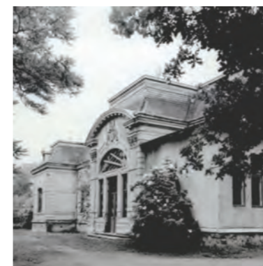
ZADNÁ ČASŤ KAŠTIELA /STAV PRED RENOVÁCIOU V ROKU 1985/
