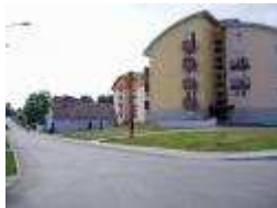
Rekonštrukcia miestnej komunikácie na ulici Cintorínska cesta, 2004
