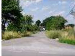
Rekonštrukcia miestnej komunikácie na ulici Nový dvor, 2004
