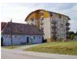
Bytový dom JOJ - 23 b. j., 2002
