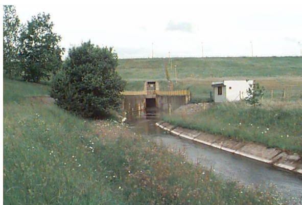
obr.č.6 Pohľad na zariadenie merania hladín a prietokov
