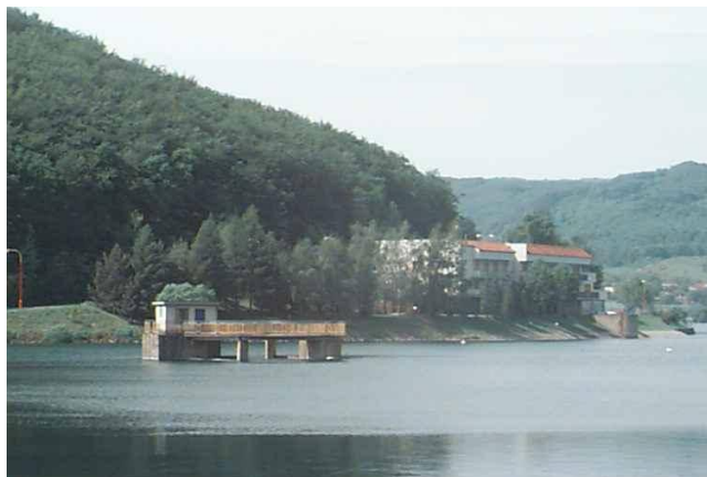
obr.č.4 Pohľad na združený funkčný objekt
