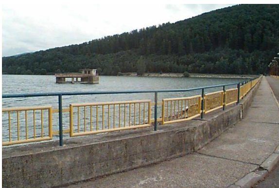
obr.č.1 Pohľad na asfaltovú časť hrádze
