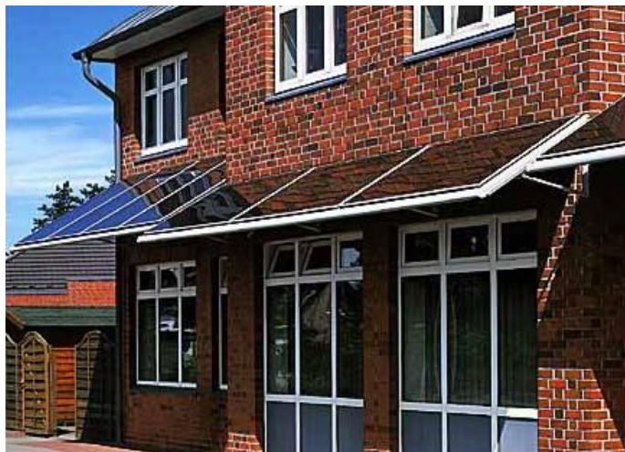
Obrázok 36 Inštalácia FV panelov na fasáde budovy
