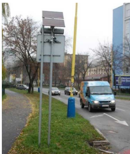
Obrázok 56 Svetelná signalizácia na solárnu energiu v Košiciach, Zdroj: ( www.seps.sk )
